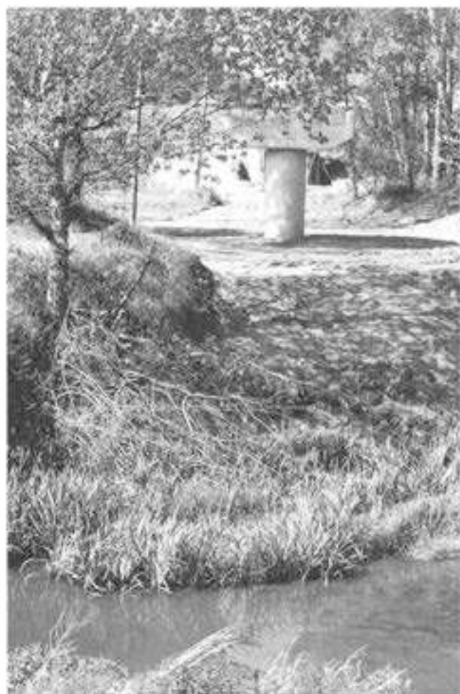
Pilastra central que suportarà l'estructura del pont sobre el riu Onyar.
