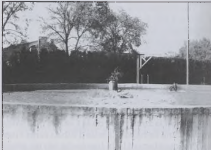
Depuradora d'aigües residuals de Quart
