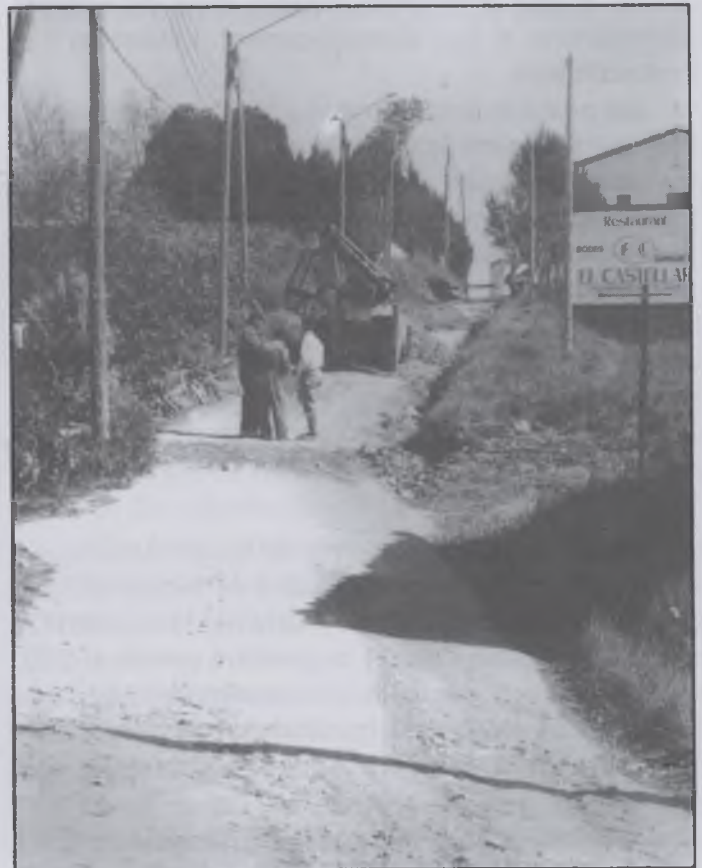
Inici de les obres en el sector del Raval
