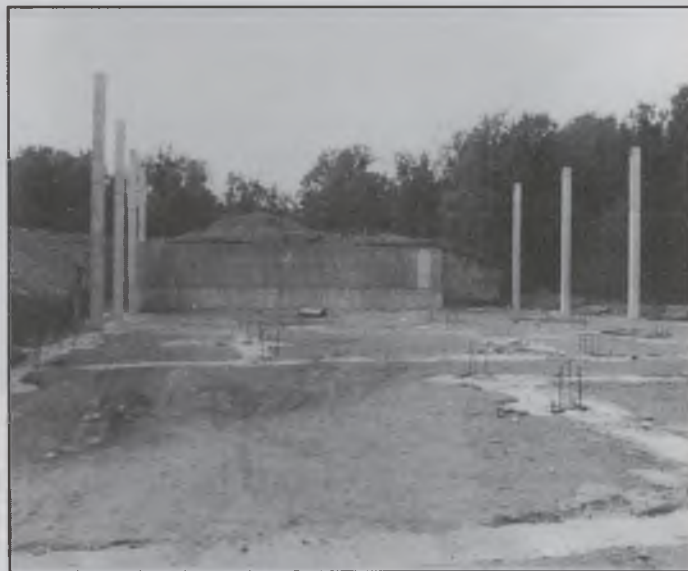
Obres Local Social de Quart.
